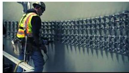
Painéis metálicos formam seções cônicas, utilizando juntas de fricção como elemento de acoplamento do conjunto.
